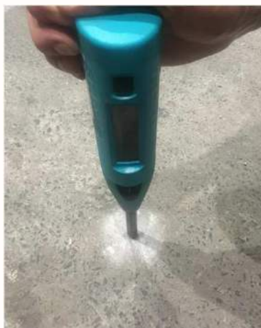
metoda nieniszcząca tester betonu
