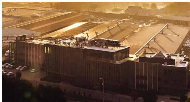
Fig. 1. The view of OKNOPLAST Sp. z o.o. in Podłęże
